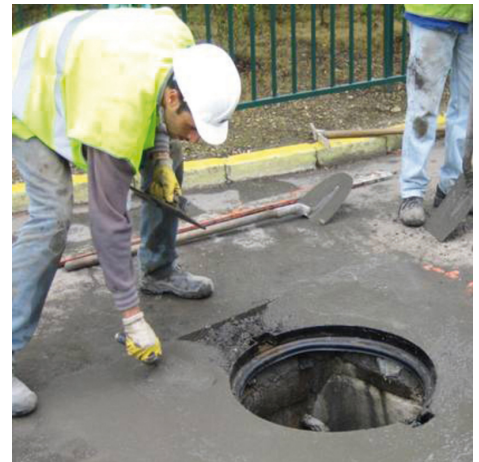
Zetten van een rioolschachtring met PCI Repafast Tixo.
